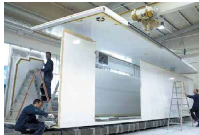
Сборка изотермического фургона
